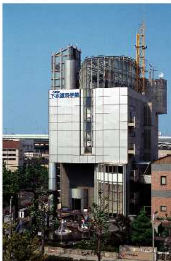
下水道科学館 電話 06-6460-1700 http://www.city.osaka.jp/ken etau/shisetsu/kagaku/
