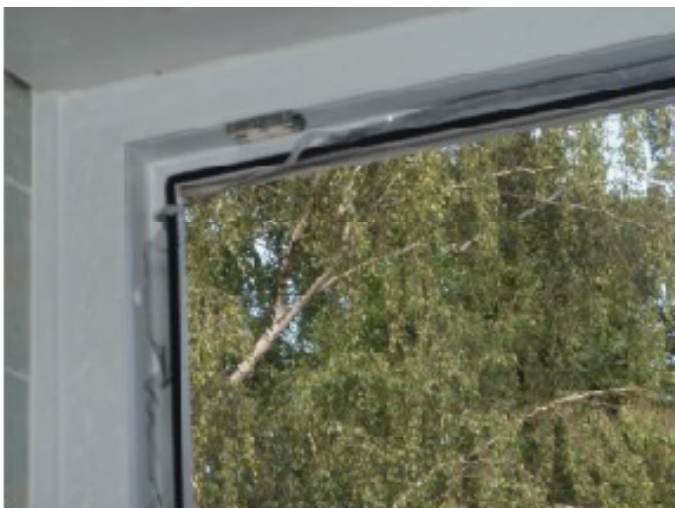
両面テープが剥がれてくると、隙間ができてしまいます。
