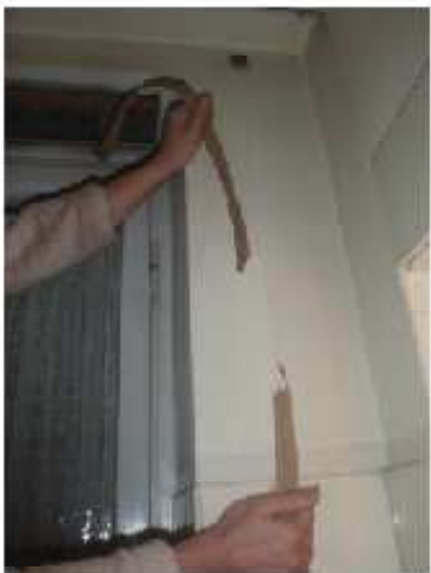
トイレのシャッターのベルトがちぎると・・・
